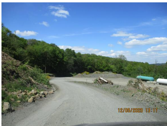
Foto1: Blick von Süden auf das Bebauungsplangelände
