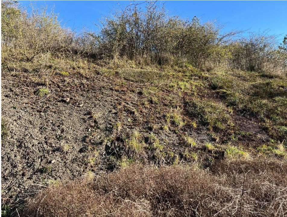
Abbildung 7: Blick auf Hang mit offenen Bodenstellen (Foto: 07.04.2026)
