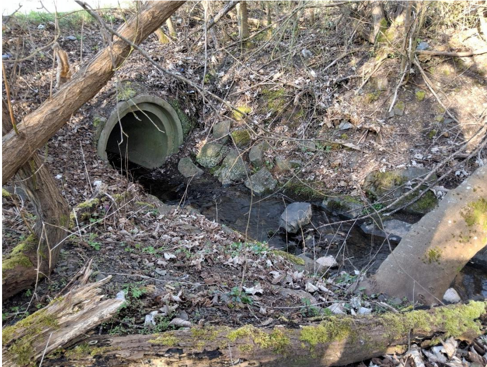
Abbildung 3: Beginn der Verrohrung des Bachs zur Überquerung der Parkplatzfläche (Foto: ISU; 07.04.2026)
