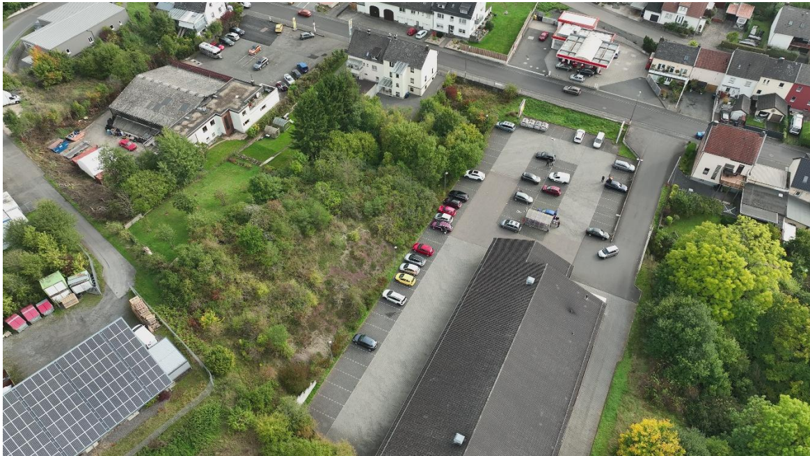
Abbildung 1: Luftbild (Drohnenflug) des Plangebiets (Foto: ISU, 29.09.2025)
