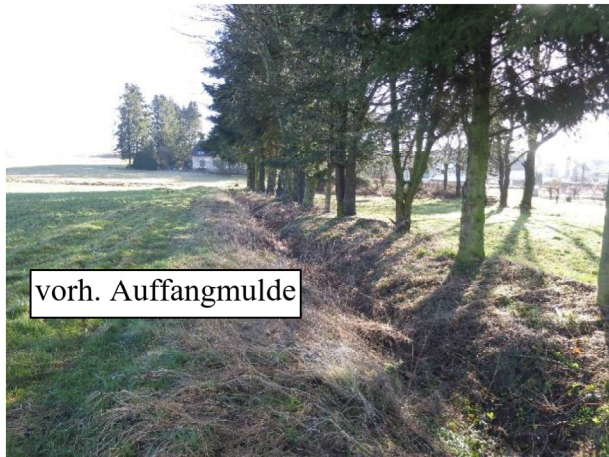
Vorh. Auffangmulde entlang der Baumreihe
