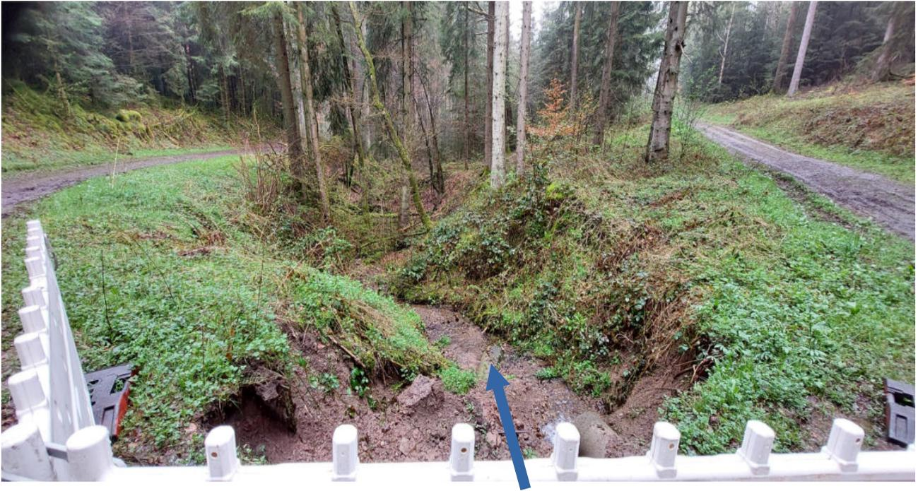
Erosion/Abbrüche durch schnell abfließendes Wasser / Entwässerung und Geschiebeverlagerung Richtung Kylltal, Gemarkung Jünkerath
